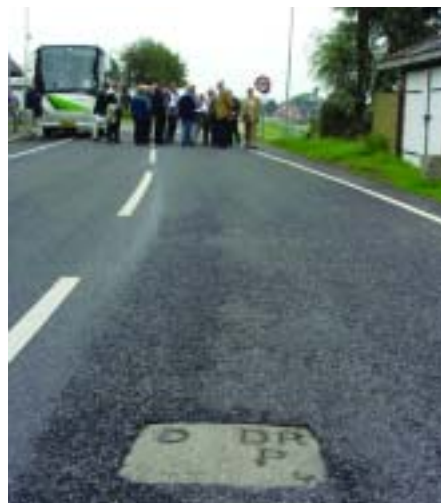
Løsningen bliver, at et grænsemærke bliver lagt ned i vejen i stedet.
